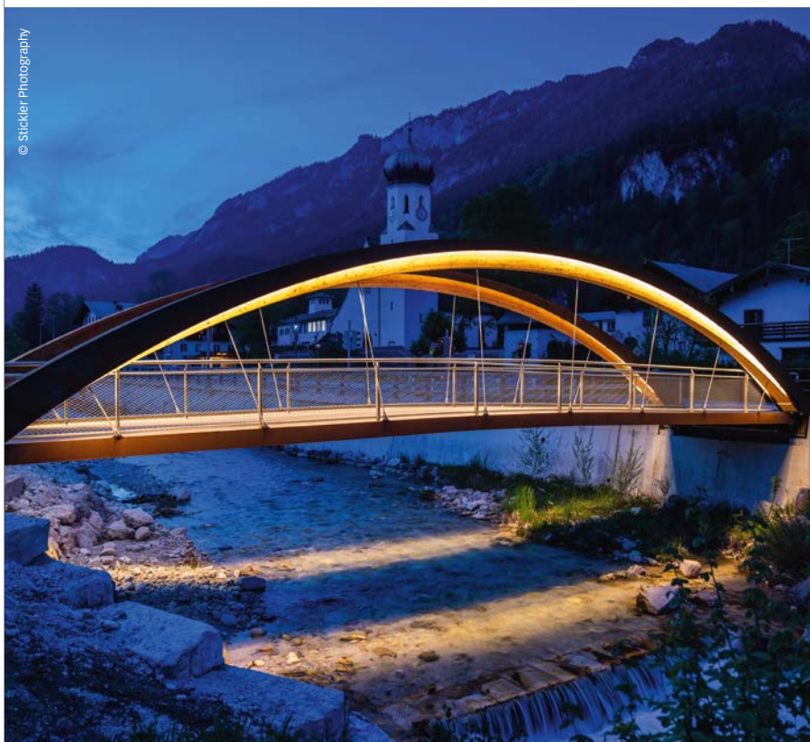
Der Holzbogen in Kombination mit wetterfestem Stahl fügt sich harmonisch in das alpine Landschafts- und Ortsbild ein
