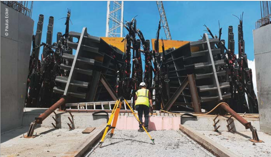
Kontrolle des Ankerblocks
